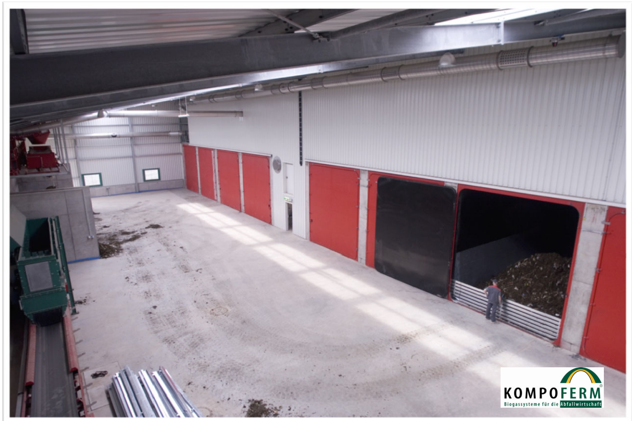
Abb. 16: Boxenvergärung (Beispiel Firma Eggersmann, Kompoferm)
